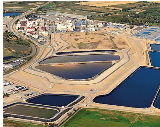
Vue aérienne du site Orano de Malvési
