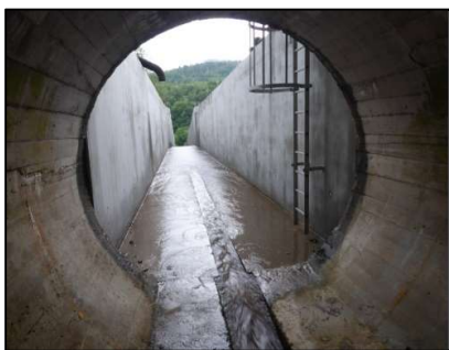
Nouvel évacuateur de crue
