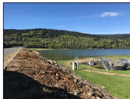
Corrolle de l'évacuateur et reniflards réhaussés
