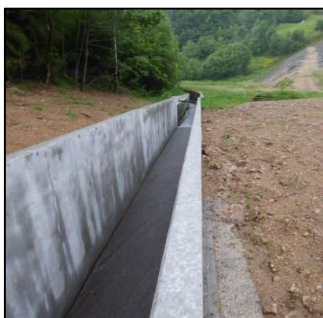
Galerie de l'évacuateur rénovée
