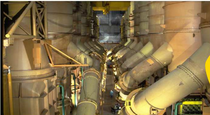
Un des groupes de diffuseurs de l'usine George Besse sur le site du Tricastin
