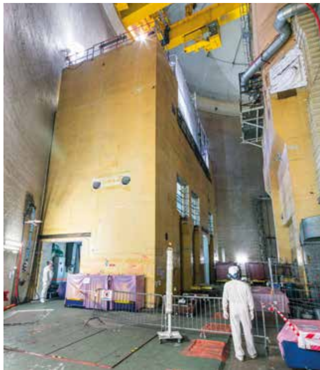
Ancien emplacement des échangeurs.
