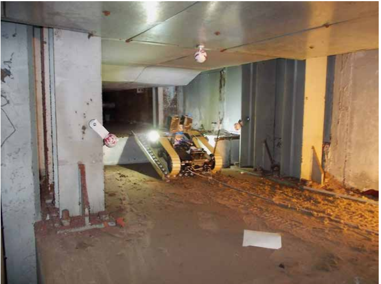
Un robot a réalisé des relevés de mesure au laser qui ont permis de modéliser un double numérique de l'enceinte réacteur.
