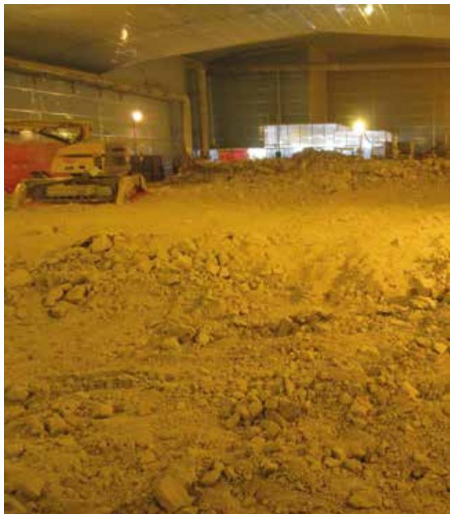
Station de traitement des effluents avant travaux d'assainissement des sols.
