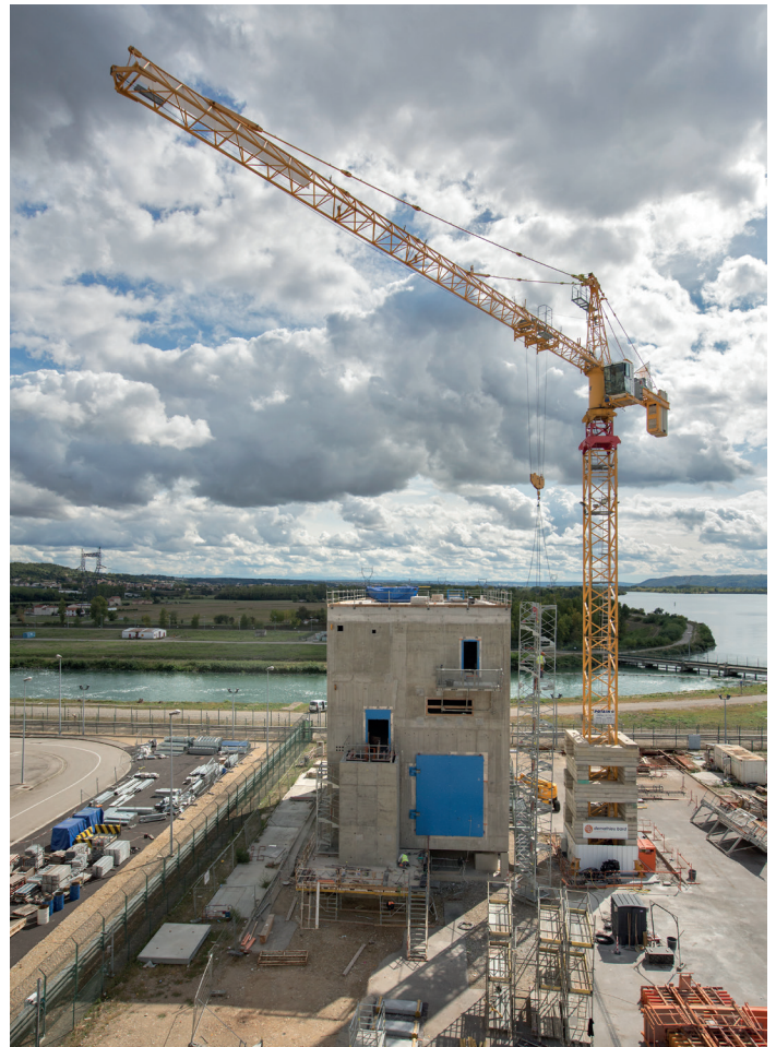
Chantier de construction des Diesels d'Ultime Secours
